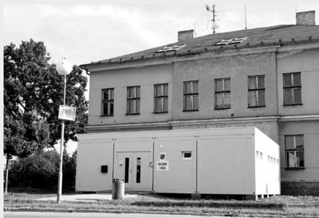
Provizorní vstup do staré školy
