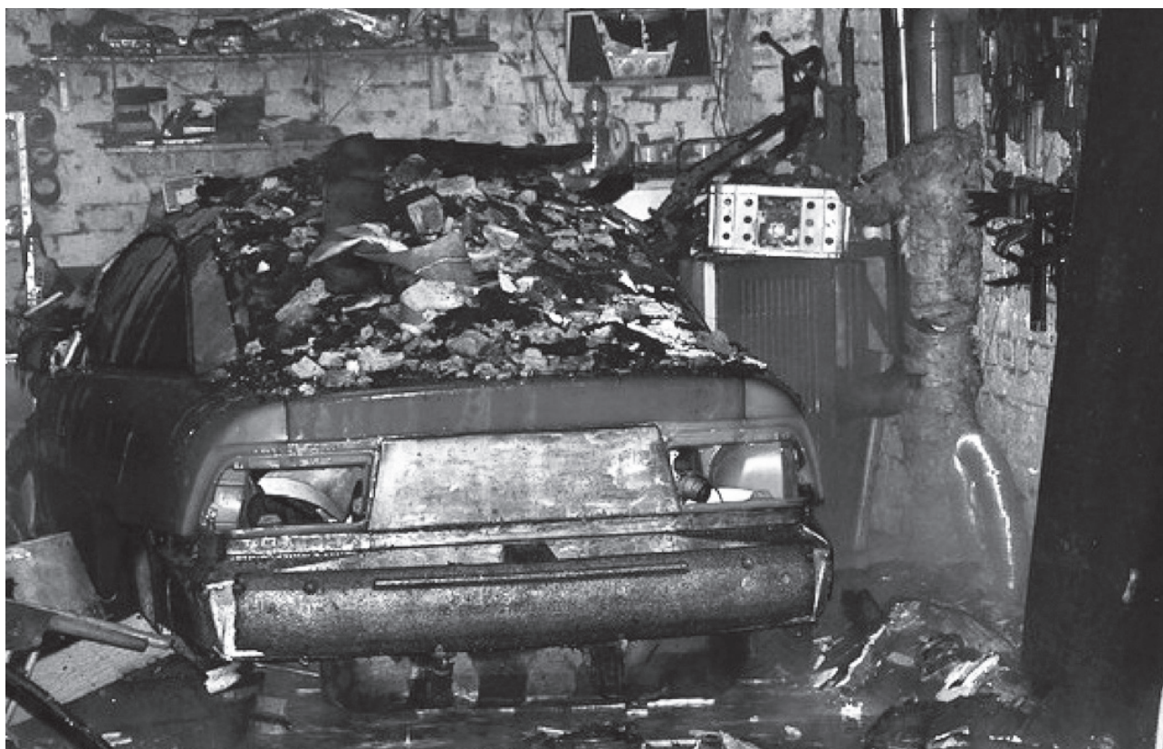
Požár rodinného domu v Mukařově
