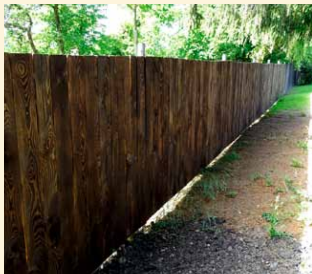
Oprava plotu u bazénu
