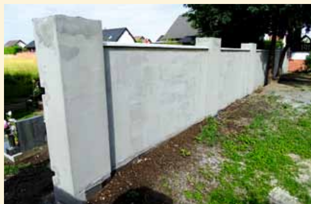
Oprava hřbitovní zdi
