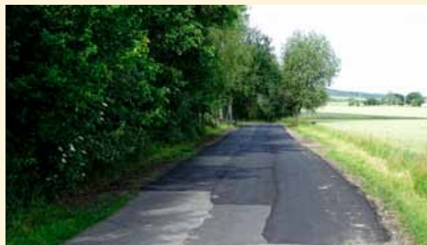
Oprava části komunikace u Chlumína
