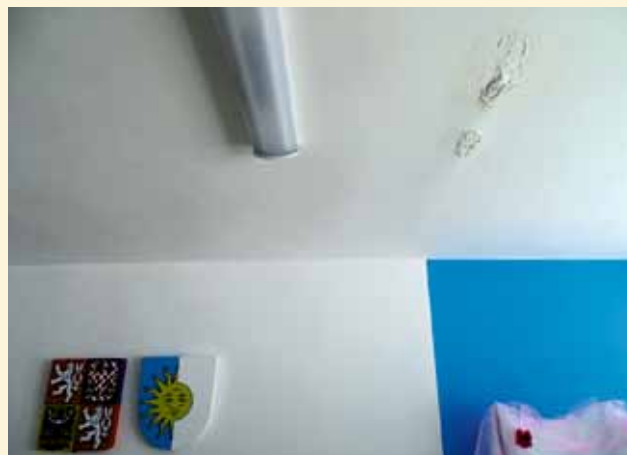
Rekonstrukce střechy knihovny
