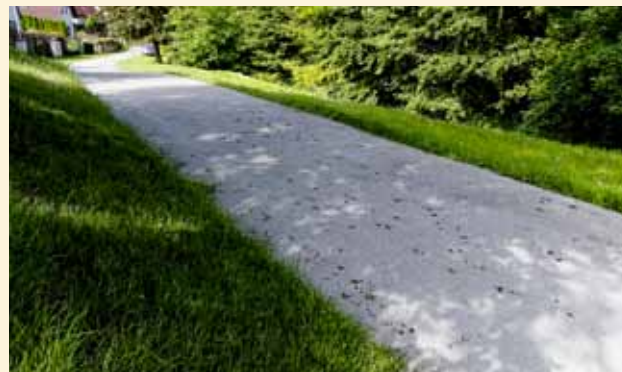
Oprava části komunikace Na Podolci
