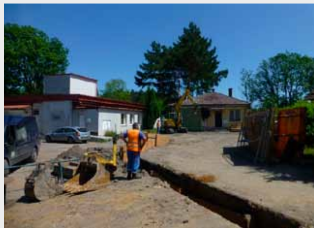
Rekonstrukce vodovodu Suhrovice
