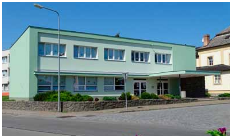
Zateplení budovy čp. 218
