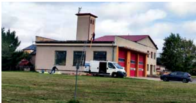
Oprava střechy na hasičské zbrojnici
