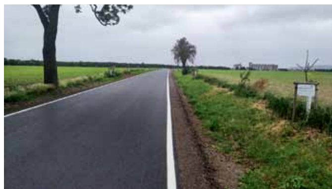
Oprava silnice na Koprník
