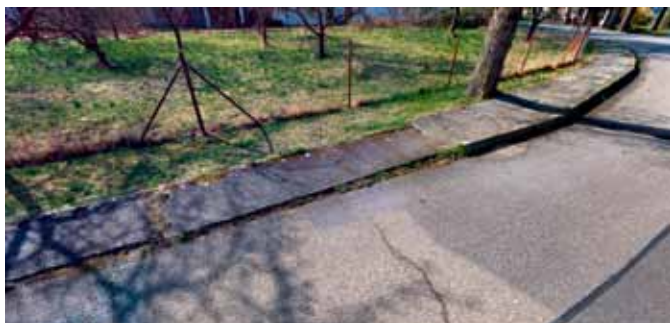
Chodník v Úhelnici – původní stav
