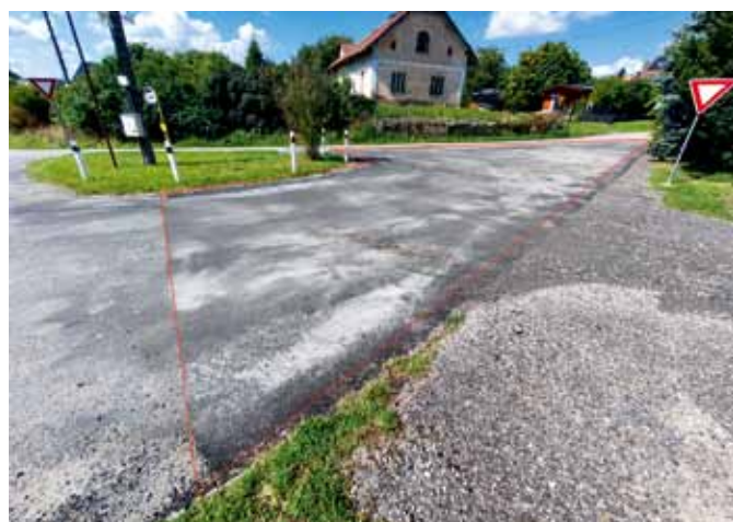
Opravená komunikace u autobusové zastávky v Malobratřicích
