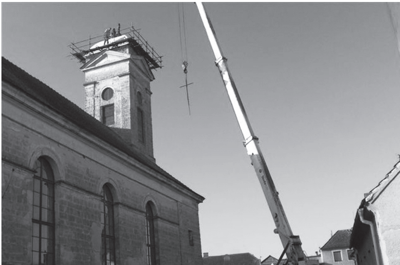
Sejmutí kříže pomocí speciálního jeřábu, foto: Vladimír Hruška
