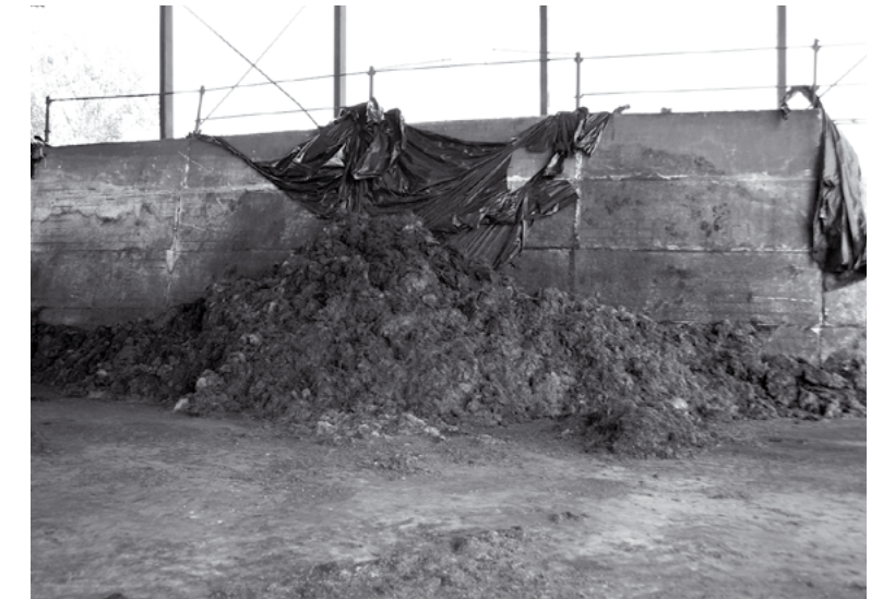
Jak to v Tyresu Kněžmost vypadalo dříve
