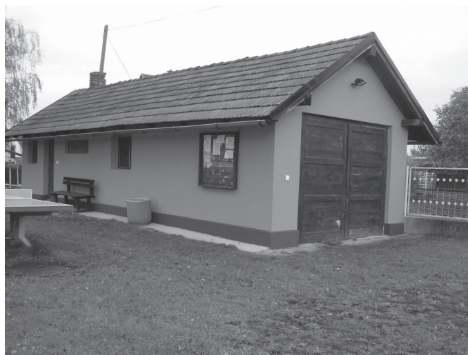
Nově opravená budova hasičské zbrojnice
