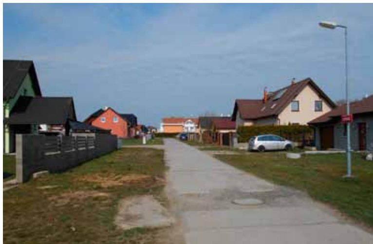
Ulice Lomená před rekonstrukcí
