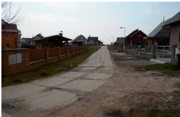
Ulice Západní před rekonstrukcí
