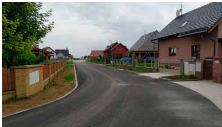
Ulice Západní po rekonstrukci
