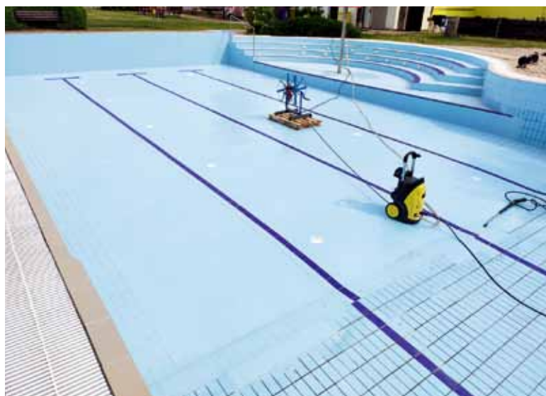
oprava bazénu ve finále
