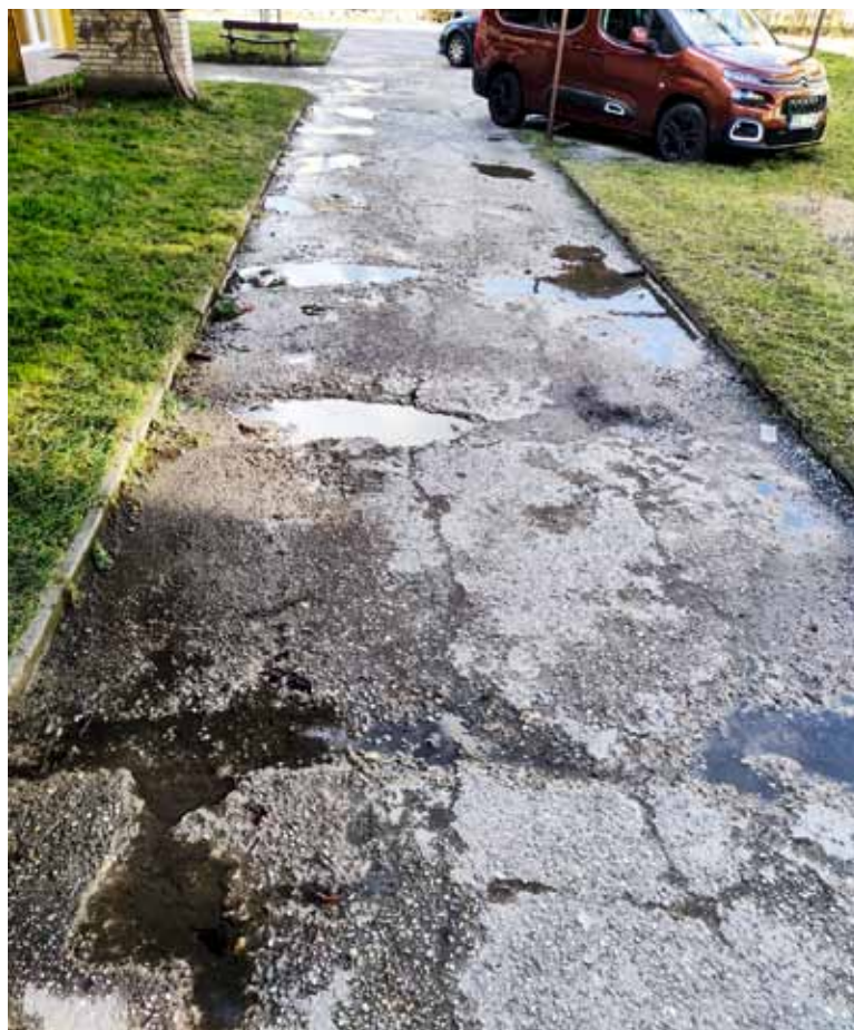
chodníky Na Mlejnici, současný stav
