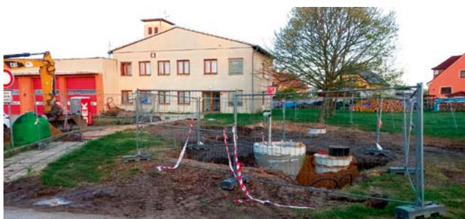
Krytá (podzemní) požární nádrž v Kněžmostu
