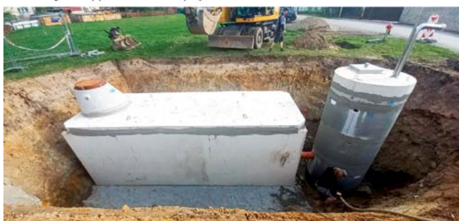
Krytá (podzemní) požární nádrž v Kněžmostu
