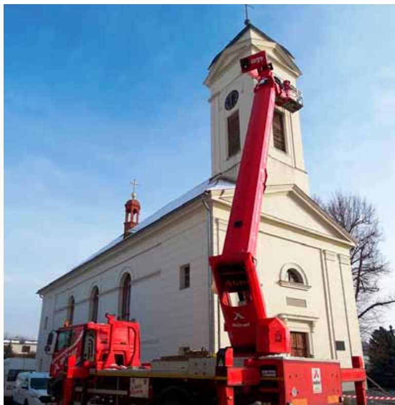
Instalace věžních hodin
