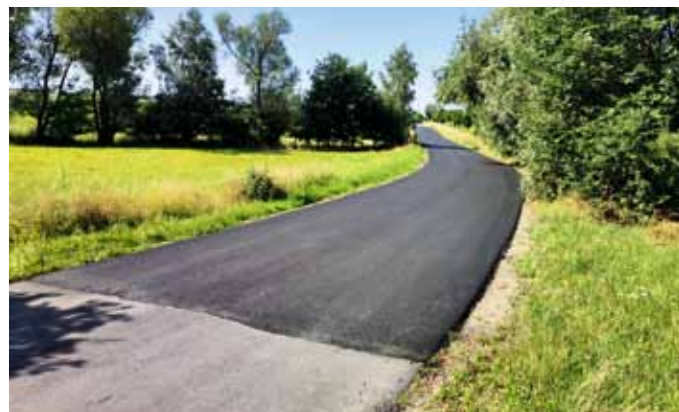
Částečná oprava komunikace Chlumín-Násedlnice
