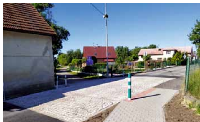
Přechodové místo v Branžežské ulici
